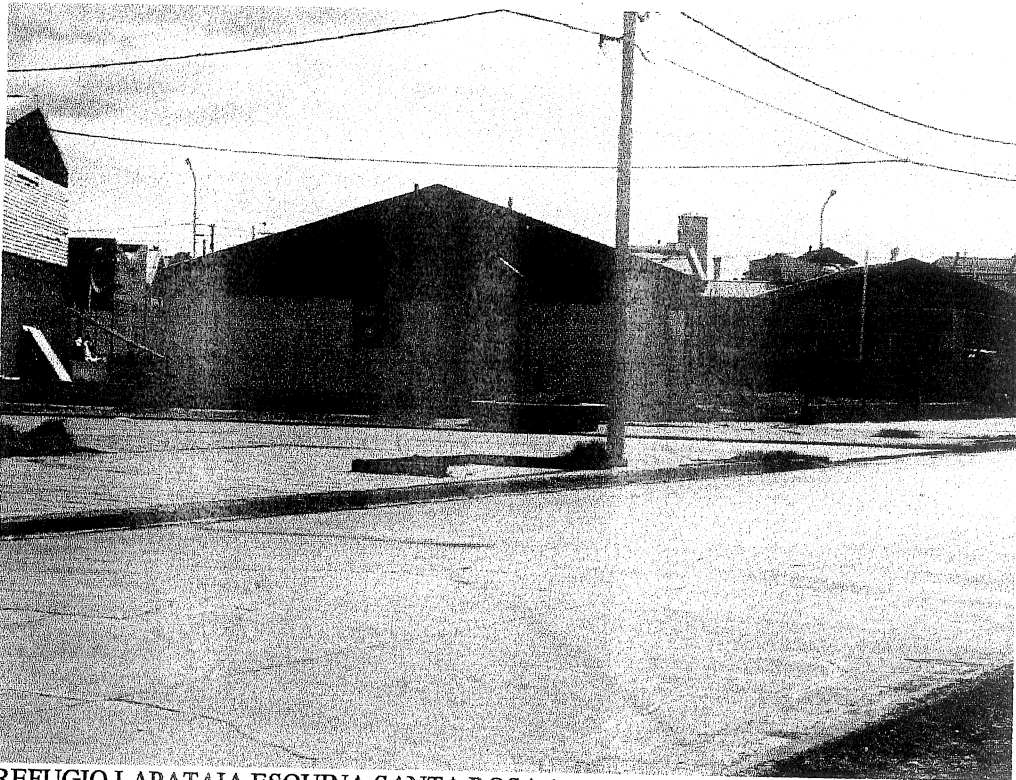
REFUGIO LAPATAIA ESQUINA SANTA ROSA 1
