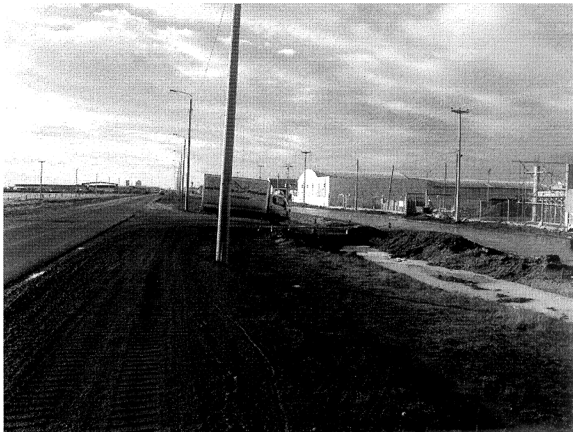
ACCESO 4 (entre Combate de Montevideo e Ing. Varela)
