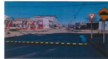
Implementación de los señales y del reductor de velocidad en la obra
