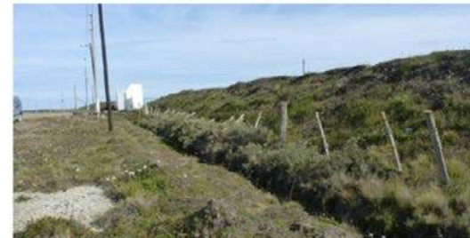
Expediente Nº 1325/2016 OBRA: "CONSTRUCCION CERCO OLIMPICO AUTODROMO RIO GRANDE"
