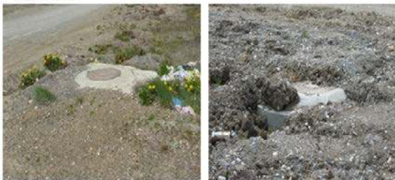
Expediente Nº 5853/2015 OBRA: "EXTENSION RED DE INFRAESTRUCTURA SANITARIA BARRIO LOS CISNES"
