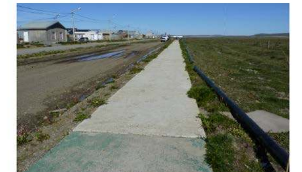
Expediente Nº 1507/2015 OBRA: "CONSTRUCCION DE SENDAS SALUDABLES - BARRIO CHACRA XI - RIO GRANDE"
