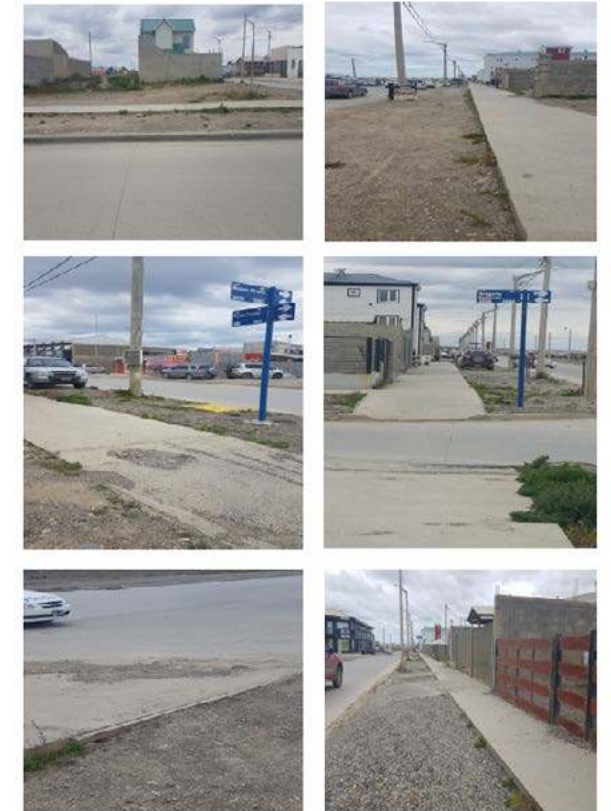
Expediente N° 1509/2015 OBRA "CONSTRUCCION DE VEREDAS BARRIO CHACRA XIII"
