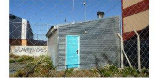
Tanque en Prefectura Naval y Aeroposta.
